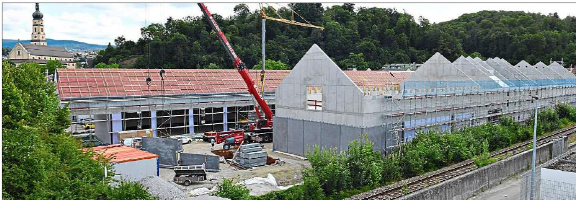
Die neue Flussmeisterstelle zwischen Schiffmeisterhaus, Bahndamm und Max-Brücke: Wo vor gut einem Jahr der Vorgänger-Bau abgerissen worden ist, steht heute bereits der Rohbau des neuen Gebäudes. – Foto: Binder
